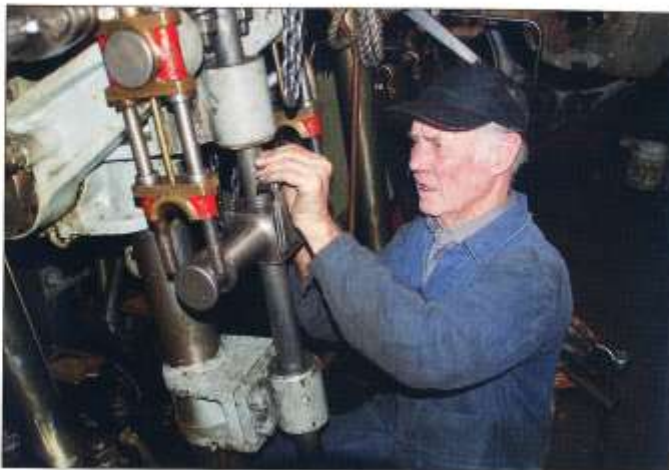
Efter renovering av skorsten och panna återstår mycket annat att göra i maskinrummet. Här är Mats Demker fångad vid ombyggnaden. Foto Bo Starmark
